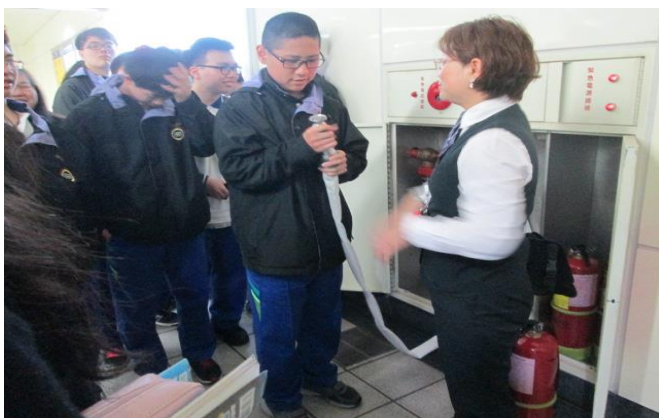
滅火設施說明及操作練習
