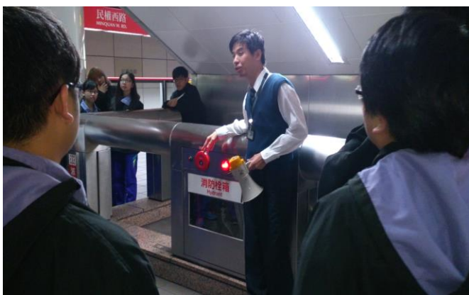
滅火設施說明
